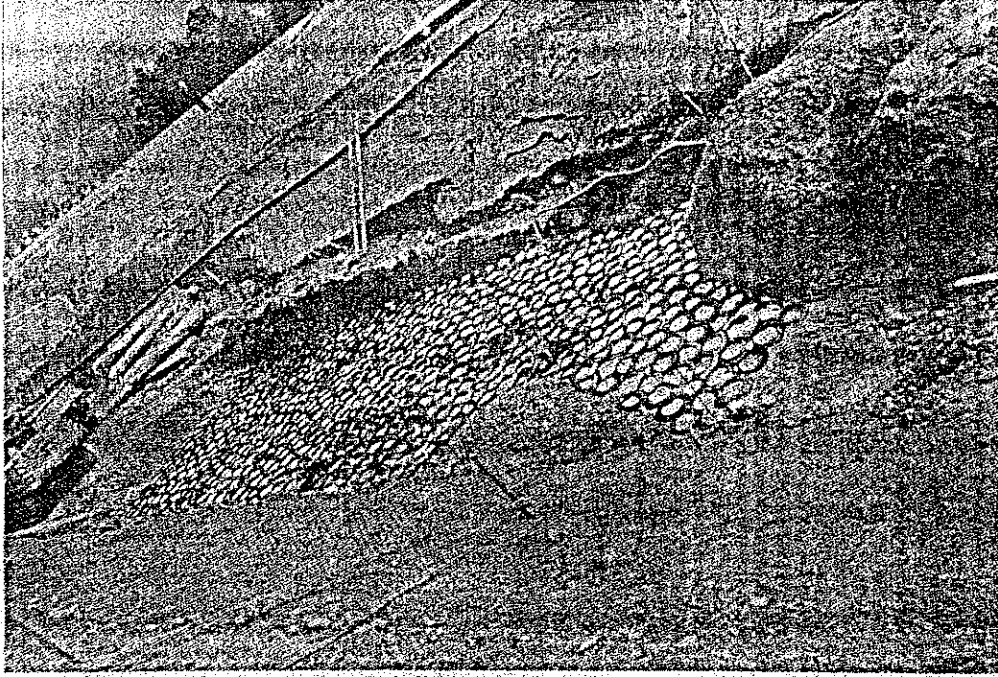
Renforcement des talus (Suisse)
